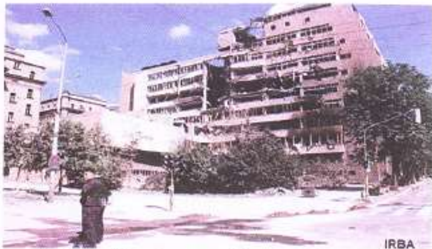
تصویر ۵۲. فضای گسترده، مانع از ریزش آوار به معبر می‌شود، اصابت موشک کروز به ساختمان فرماندهی ارتش یوگسلاوی - بلگراد، ۱۹۹۹
